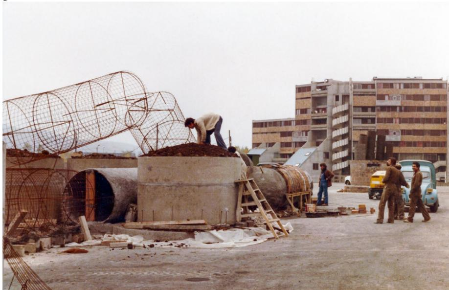
Construction du géant allongé, à côté du futur 20 place des Géants : on distingue la structure métallique, recouverte par endroit de ciment, et le parement de brique en cours de pose, en 1979. (photo : archives personnelles de Klaus Schultze)
