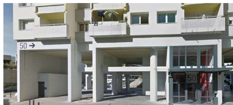
Transparence + hall réhabilité (50 de l'Arlequin)
