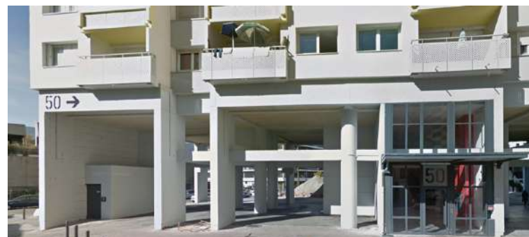
Transparence + hall réhabilité (50 de l'Arlequin)
