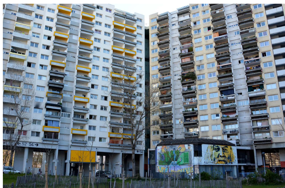
Les 52, 54 (rénovés, à gauche), 60 et 90 (à droite) galerie de l'Arlequin, en mars 2021. (photo : BB, Le Crieur)
